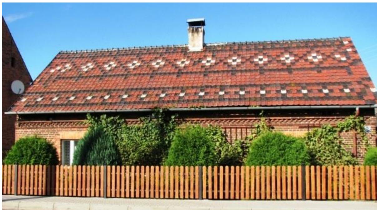
Ryc. 1. Wzory na pokryciu dachowym budynku mieszkalnego w Zagwizdzu (gmina Murów)
