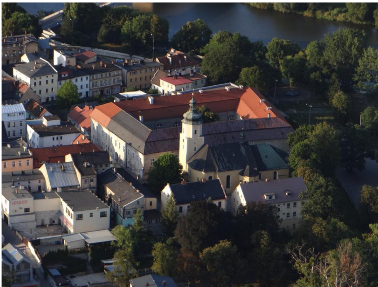
Rys. 38. Pałac w Krapkowicach
